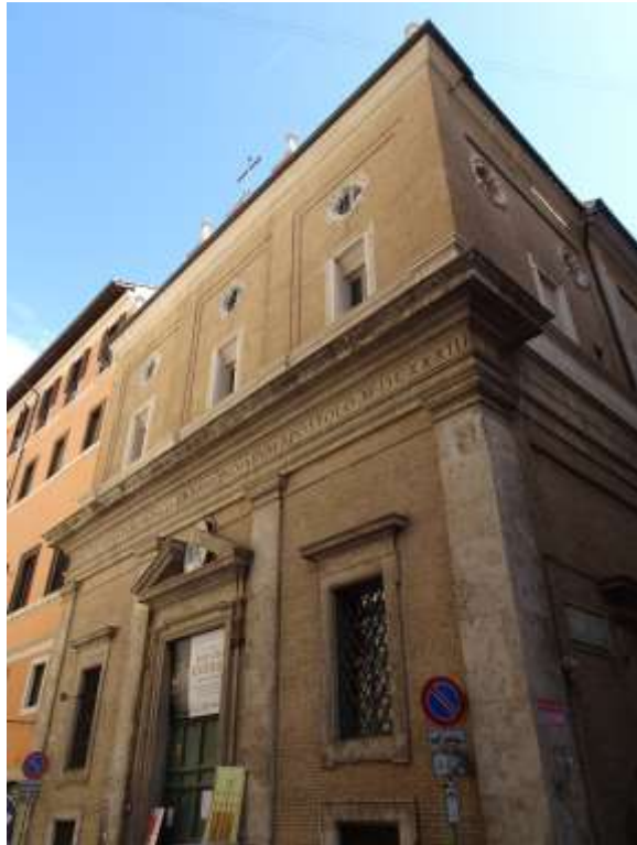
Fig.1. Oratorio di San Francesco Saverio, detto del Caravita, facciata, Roma Via del Caravita.
